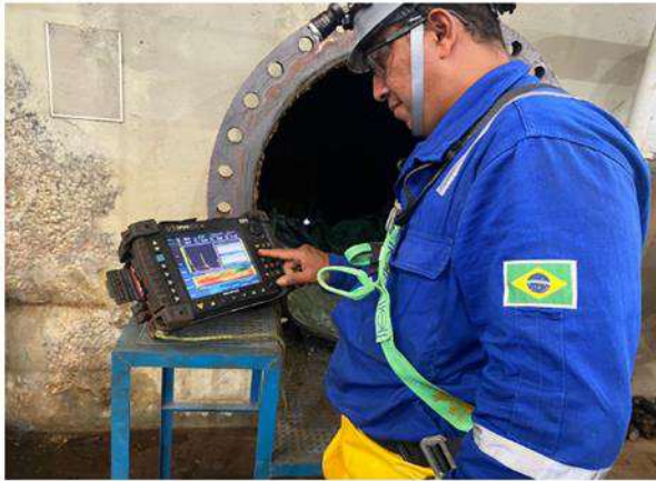
Figura 6: Ensaio de ultrassom interno a tubulação.
