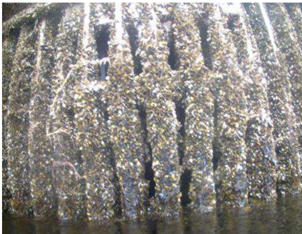
Figura 8: Limpeza de grade da tomada d'água.
