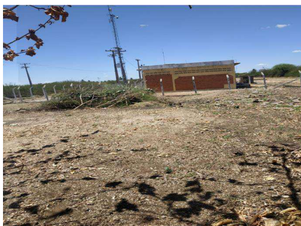
Figura 11: Limpeza do pátio externo EBs.
