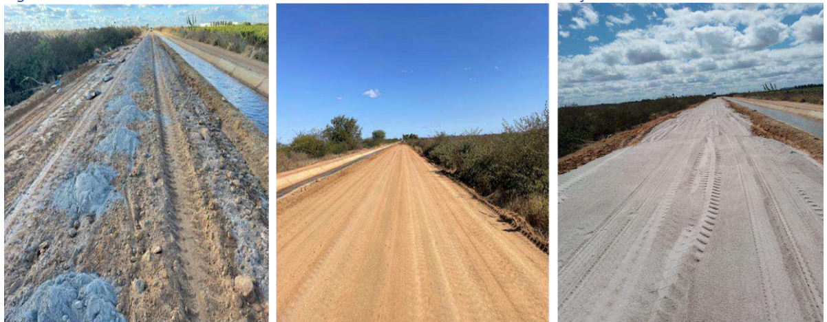
Figura 2: Tratamento de base com adição de pó de pedra e cimento.
