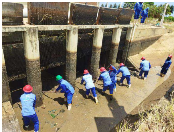
Figura 10: Limpeza de poço de sucção EB's
